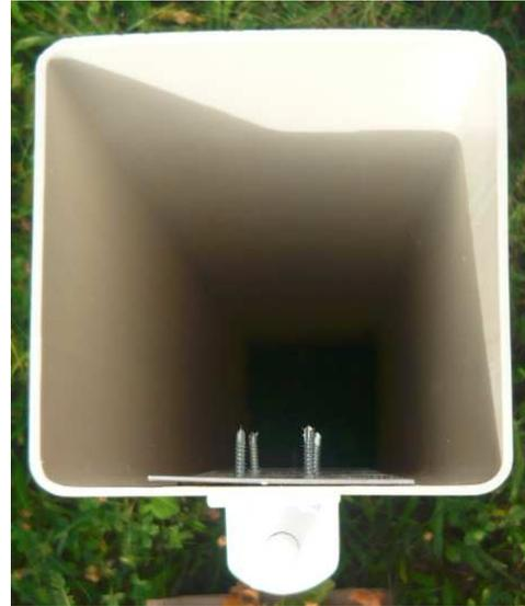
**Alternativ können Tor-Pfeiler auch mit Beton ausgegossen werden, so dass die Halterungen später angedübelt werden können.**
