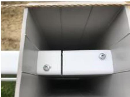
Um ein Verschieben der einzelnen Querlatten zu verhindern, innerhalb des Pfostens links und rechts kleine Schrauben in die obere Querlatte einsetzen. (siehe Bild)
