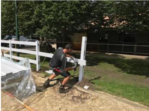
Nun die Querlatten mit 5,0m Länge durch die eingefrästen Löcher der Zaunpfosten schieben. **Für eine höhere Stabilität die Querlatten im Versatz einschieben. (siehe Bild)**
